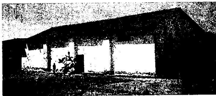
Fig. 5. Parte posterior de la troje de Lagunillas, Michoacán. Foto Luis A. Torres Garibay.
