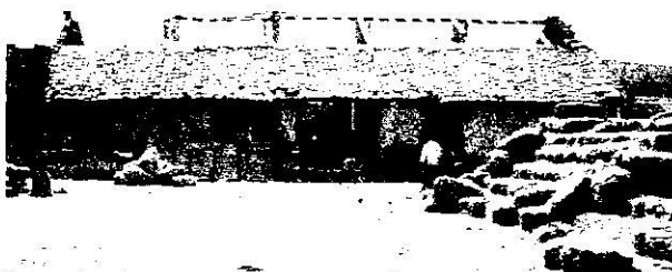
Fig. 2. Troje de dos naves, municipio de Epitacio Huerta, Michoacán. Se advierten los pilares centrales que sostienen el caballete de la cubierta. Foto Luis A. Torres Garibay.
