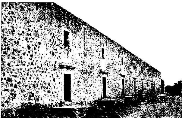
Fig. 3. Troje unida a la casa grande, con naves cubiertas por bóvedas de cañón corrido. Cada acceso corresponde a una nave con la cubierta abovedada, la agrupación es de doce naves. Mexquitic, S.L.P. Foto Luis A. Torres Garibay.
