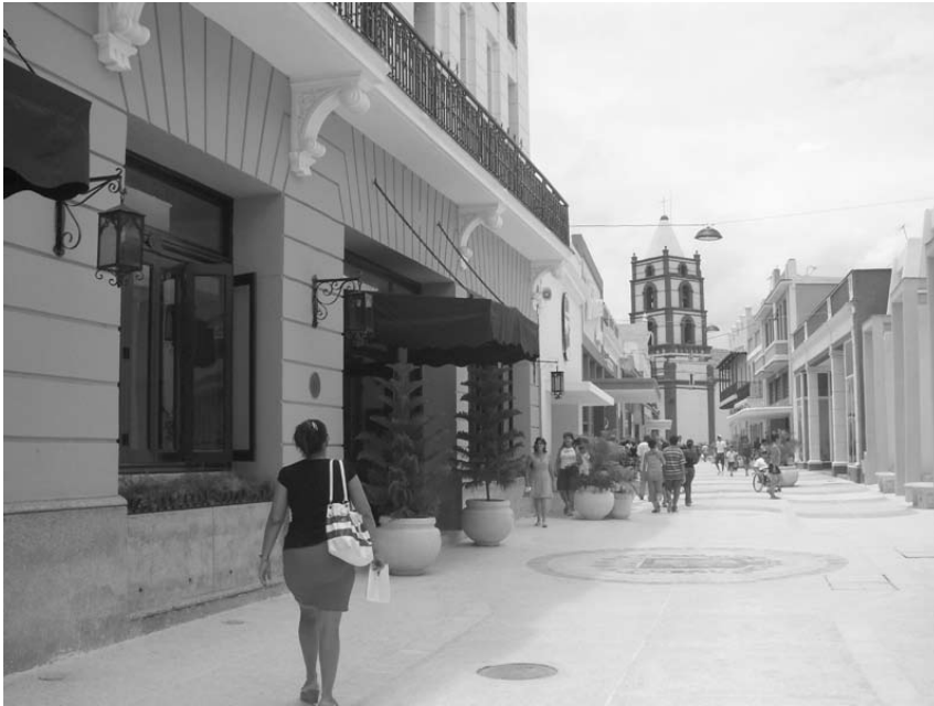
Fotografía 1. Vista de la calle Maceo, rehabilitada integralmente, que comprende el soterrado de la infraestructura técnica, repavimentación y dotación de mobiliario urbano; así como la rehabilitación de varios inmuebles de valor.
